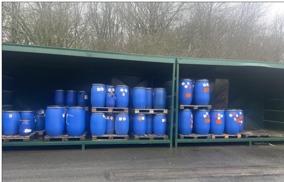
Billede 3. Oplag af kemikalier i container med opsamling og under halvtag.
