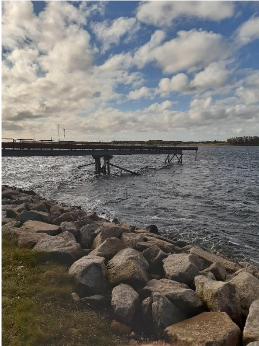
Foto 2. Anlæg til indspuling af sediment fra pram via anløbsbro til venstre og fast rørledning til landfelterne til højre.
