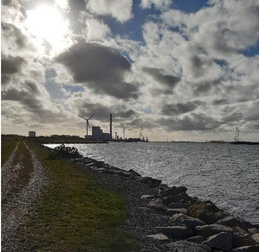
Foto 5. Deponiets afgrænsning mod Limfjorden med stenfæstning.
