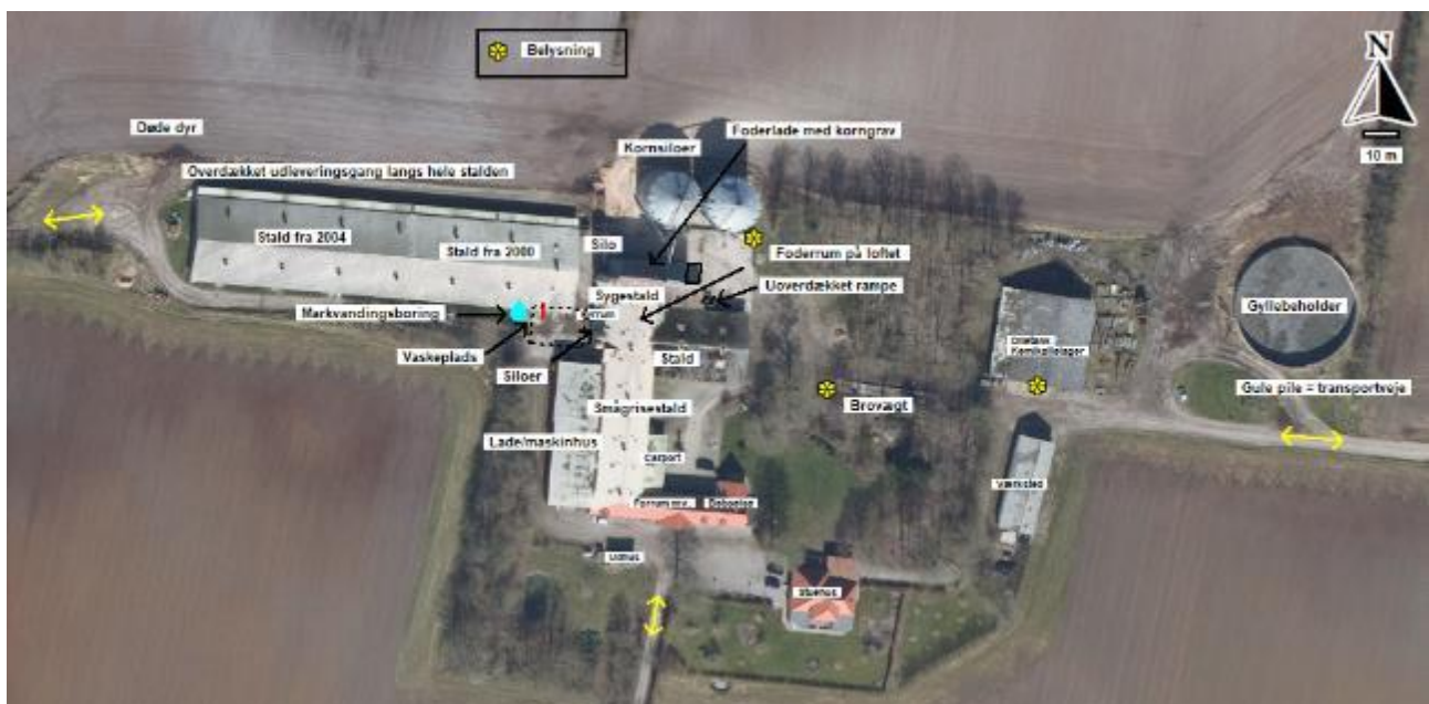
Figur 10: Støjkilder (og udvendig belysning) Glaservej 1
