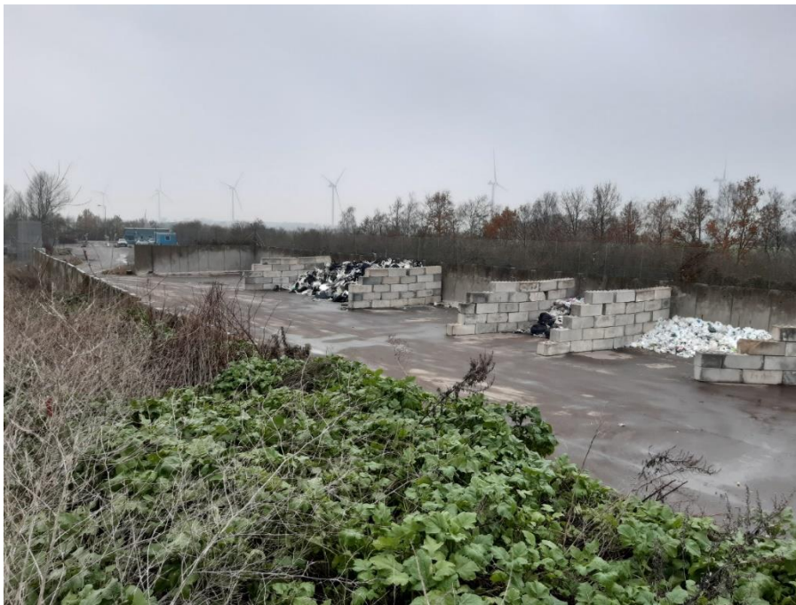
Sorteringsplads på Miljøcenter Gerringe
