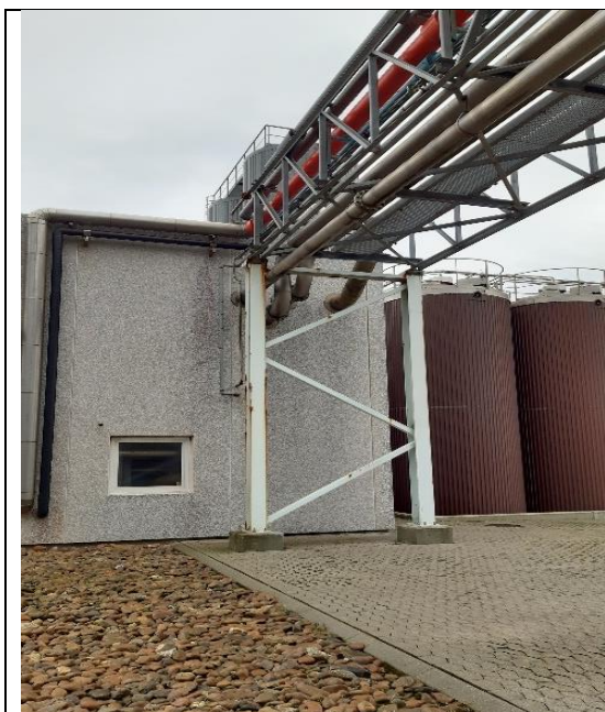
Foto 8: Rørbro fra servicesbygning til produktionsanlæg, hvorfra brandskum føres til produktionsanlæg.
