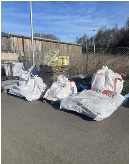
Billede 5. Udendørs opbevaring af asbest.
