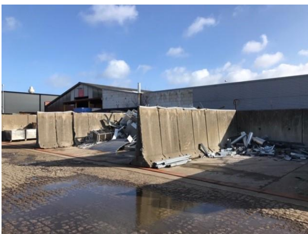
På pladsen er indrettet båse til metaller. Båsene er indrettet med betonbund og adskilt af betonelementer
