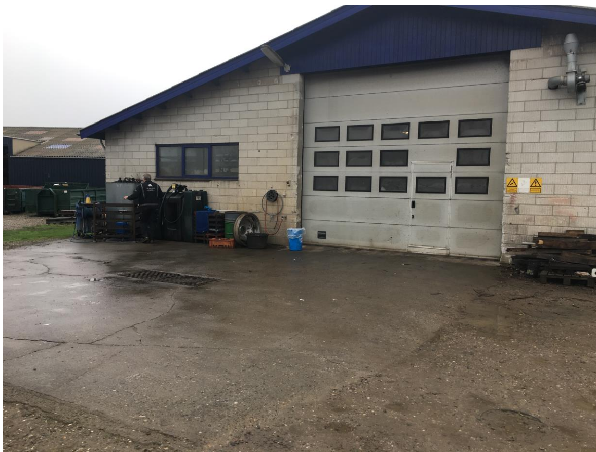
Vaskepladsen, hvor dieselstander og spildolietank er placeret.
