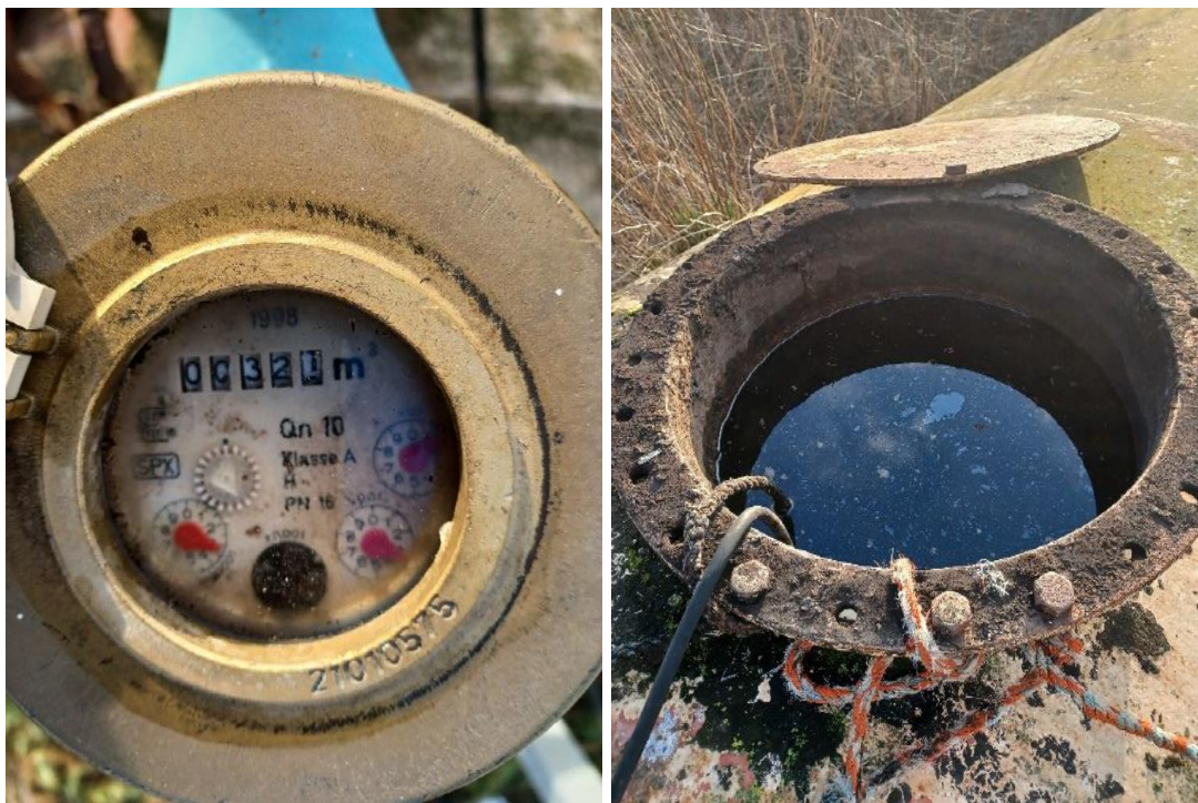
Billede 5 Måler og vandstand i tank ved tilsyn d. 3. januar 2023
