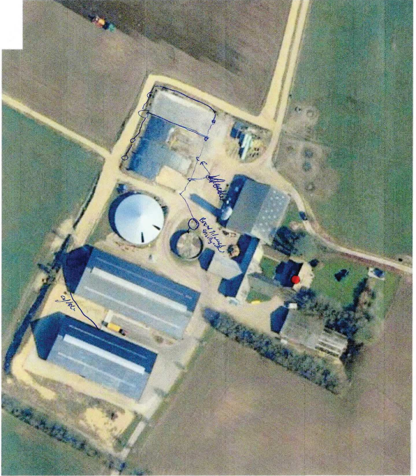
Afløb – gyllesystemer og dybstrøelse – Bjerrevvej 69 7400 Herning
