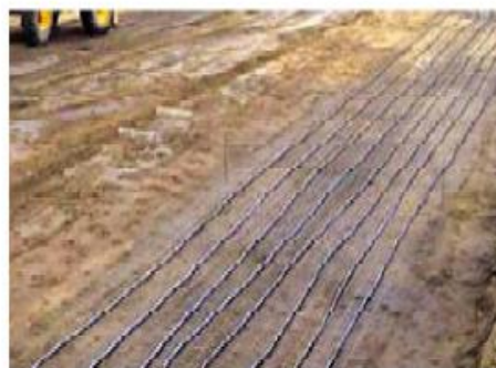
Figur 2: Eksempel på placering af køleslange i bunden af en kommende gyllekanal.
