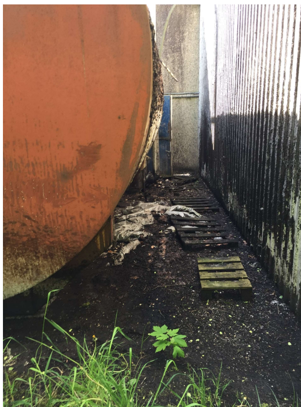
Tank til fedt - fedtaflejringer ned af tanken + på jorden - bag ved fabrik mod nord.
