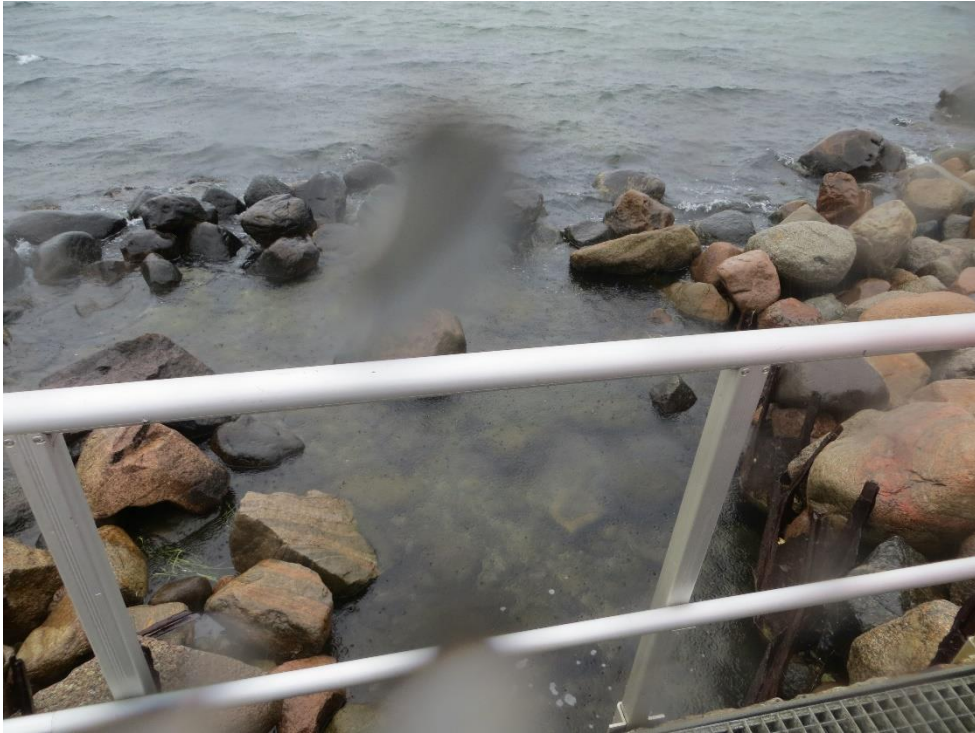
Der er 2 udløb af kølevand, hvor der også tilføres diverse afløb. Dette er det østligste udløb.
