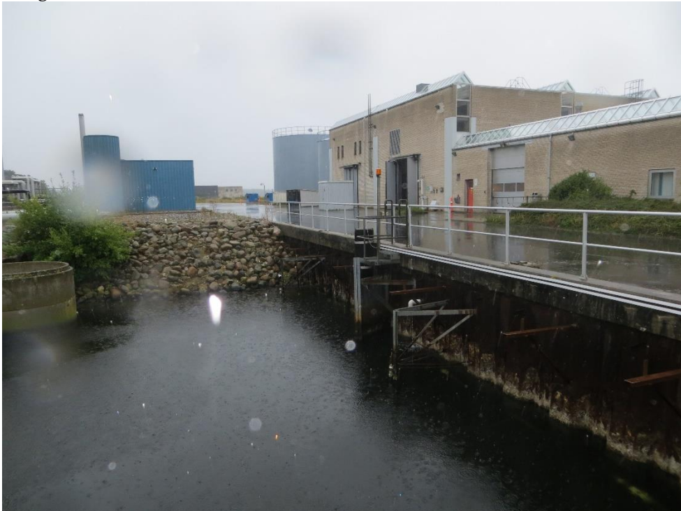
Den vestligste kølevandskanal, hvor der også er diverse tilløb af andre spildevandsstrømme. I forbindelse med revurderingen skal spildevandforhold nærmere gennemgås og vilkår skal revurderes.
