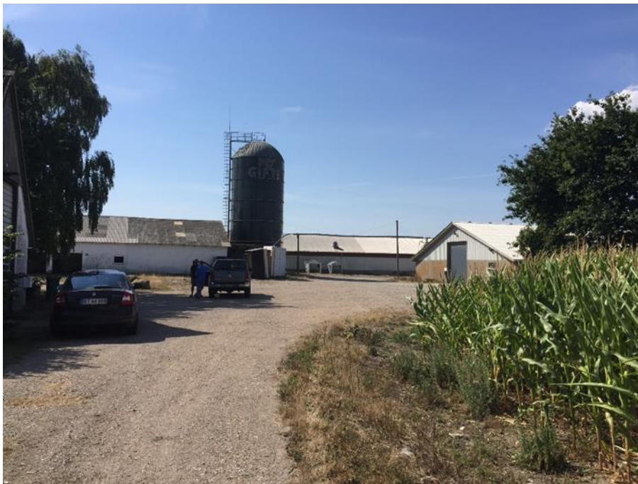
Eksisterende anlæg – indkig fra indkørslen øst for ejendommen
