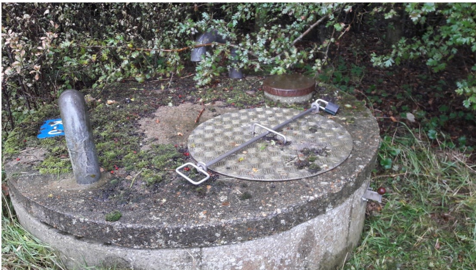
KO Boringen er aflåst.
