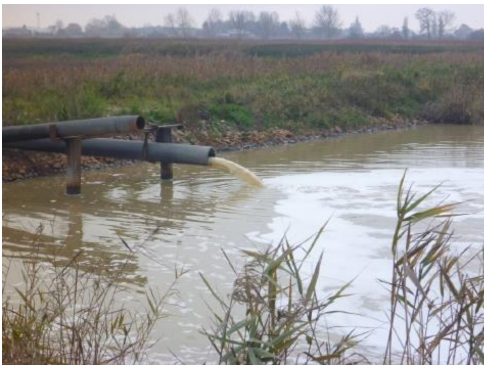
Foto 5. Udløb fra jordbassin til klaringsbassin.
