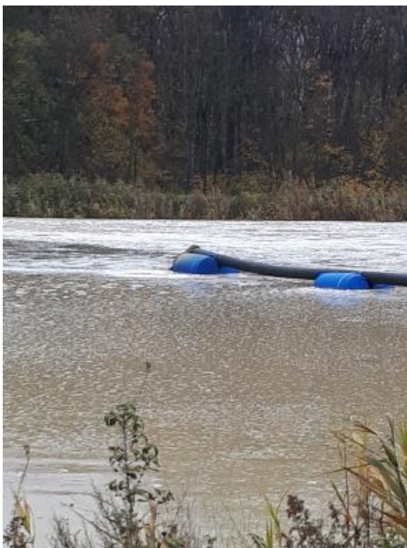
Foto 4. Udløb af roejordsvand til bassinkolonne 1.
