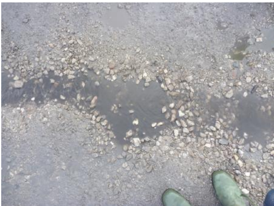
Foto 7. Vand fra befugtning, løbende hen over grusvejen til nærmeste vandløb.
