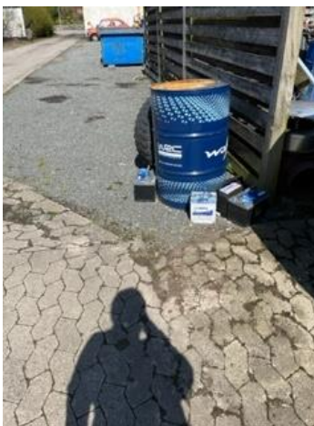
Figur 2 Batterier stod uden for egnet kasse til opbevaring af batterier og ikke på fast belægning.
