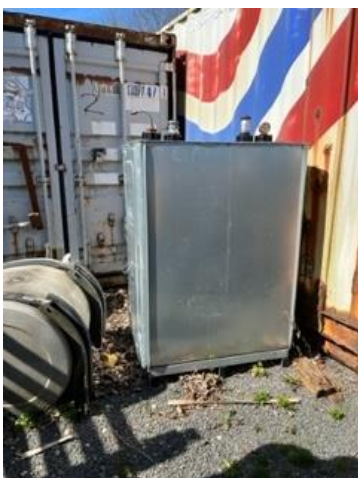
Figur 5. På matriklen sås anden beholder der er anses for at være en egnet beholder til opbevaring af spildolie. Beholderen skal placeres så spild kan holdes inden for et afgrænset område og uden afløb til jord, grundvand, overfladevand og kloak, samt beskyttet mod vejrlig.
