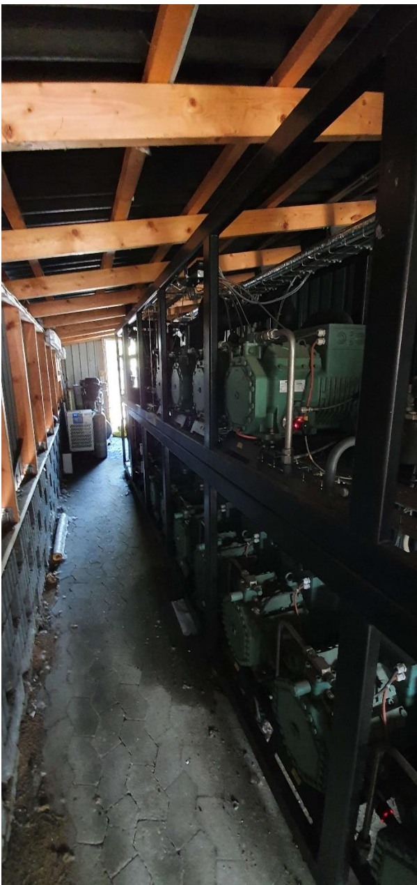
Skur med kølekompressorer er kun åbent i den ene ende og kan vanskeligt komme af med varmen.
