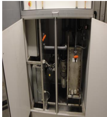
Chlorelektrolyse anlægget.
