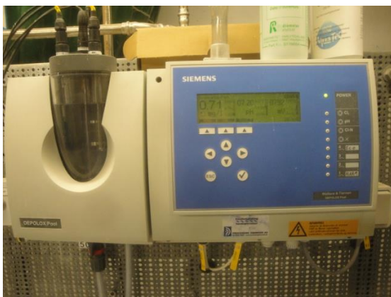
Chlor-/pH-styring fra Siemens.
