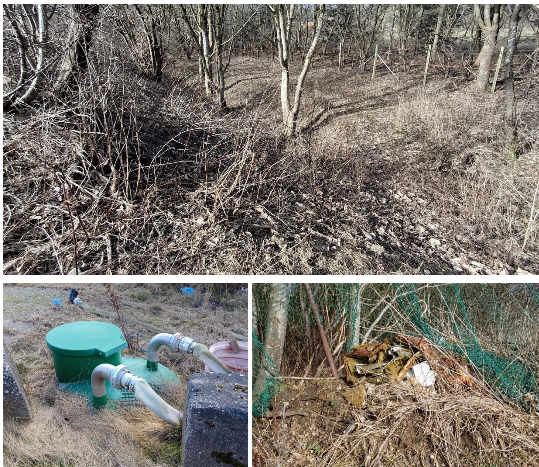
Figur 9. Affald på anlægget. Øverst: Området nord for anlægget var frit for affald. Nederst tv: Tidligere ventilbrønd ved etape 6. Nederst th: Affald langs skrænten på den nordlige del af etape 3A.
