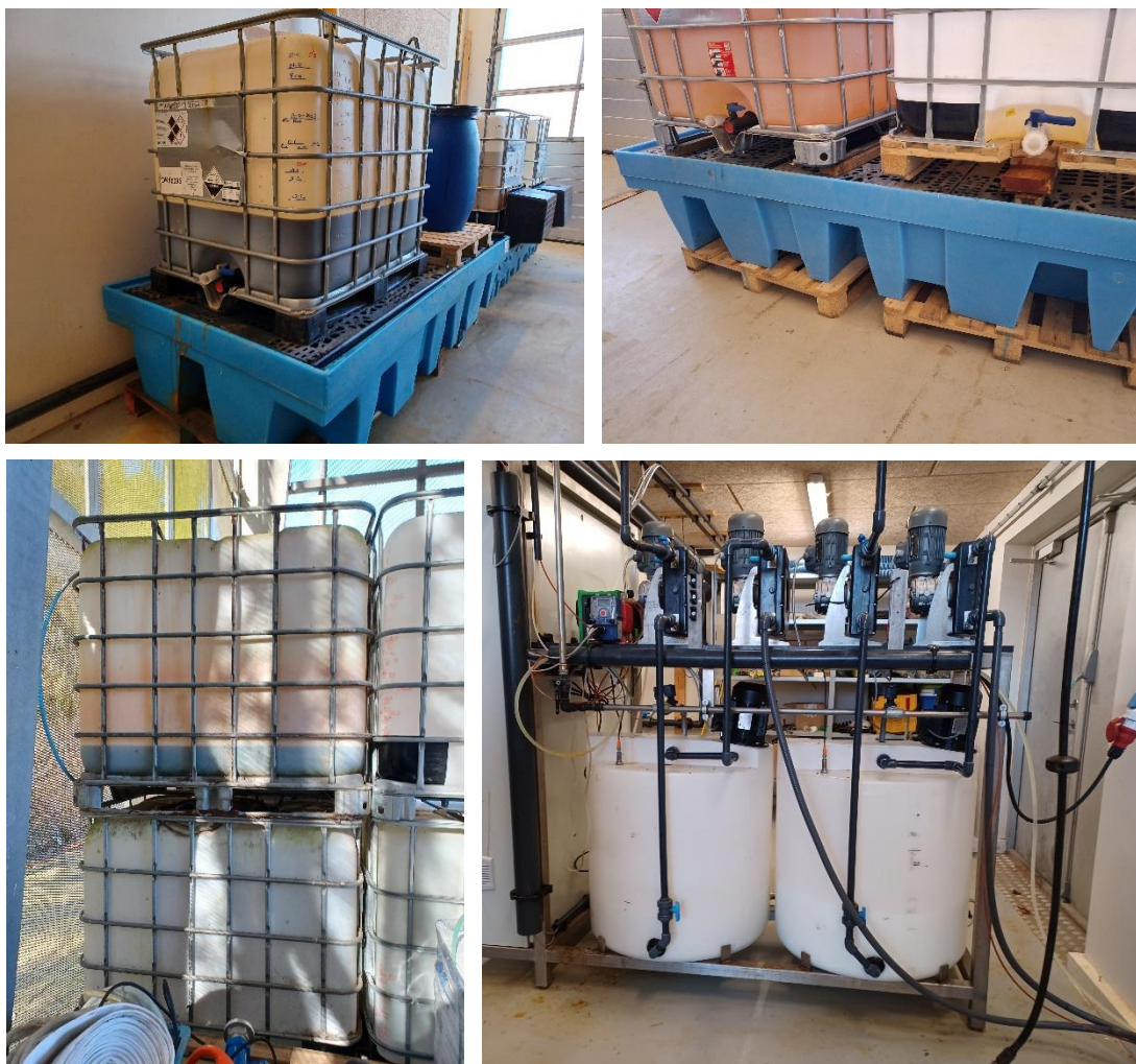
Figur 10. Oplag af kemi. Øverst tv og th: oplag af kemi til brug i PFAS-renselanlæg på spildbakker. Nederst tv: Pallettank i vognly med indhold af kemi (indholdet kan ses som en mørk skygge i bunden af den øverste tank). Nederst th: Opblandingstanke til flokkuleringsmidler.
