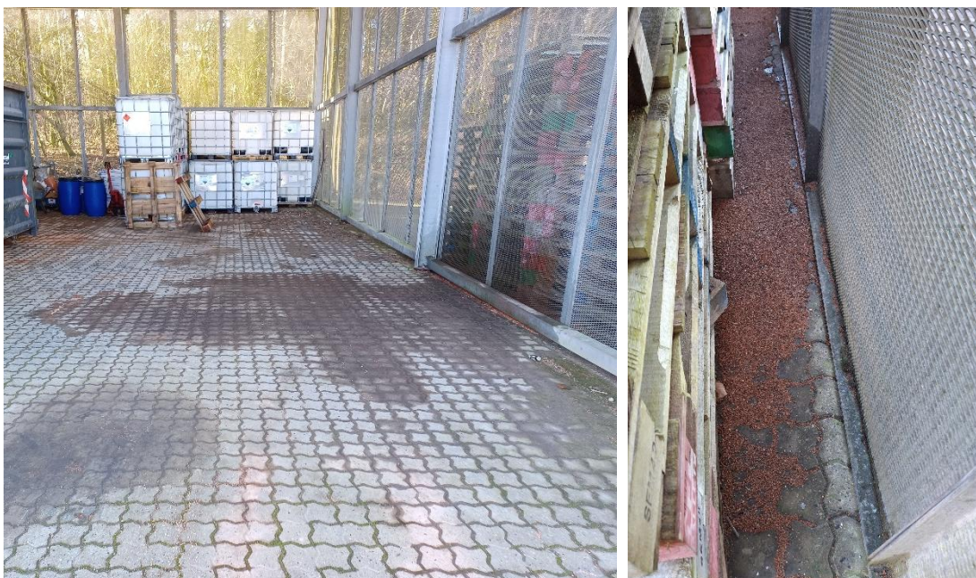
Figur 13. Spor efter uheld med hydraulikolie. Tv: mørkfarvning af sf-sten, hvor spildet er sket. Th: kattegrus til opsug af olie udenfor vognly.
