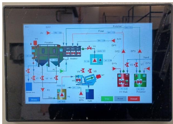
Figur 6. PFAS-renselanlæg. Øverst: PFAS-renselanlæg. Midterst: dosering af kemikalier til perkolat i behandlingstank. Nederst tv: Rejectvand fra slamafvandning. Nederst th: Skærm til styring af renseprocesser.
