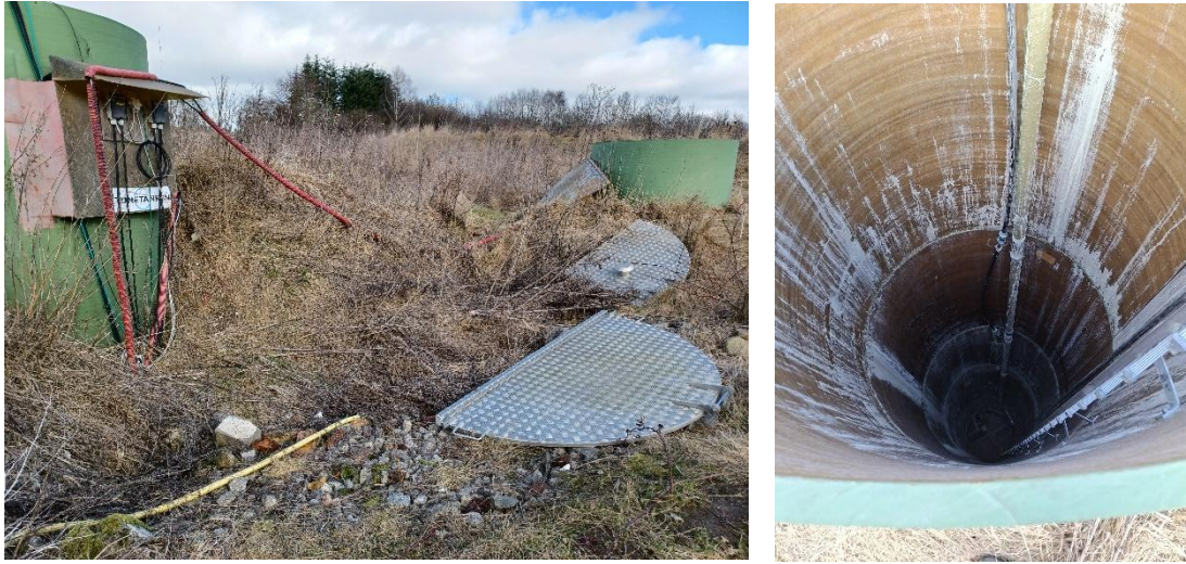
Figur 2. Perkolatbrønde uden låg, Tv: Perkolatbrønde på etape 6. Th. Kig ned i perkolatbrønd.
