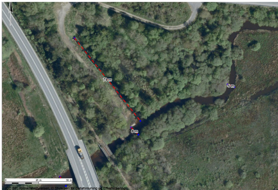
Figur 3.23 Grindsted Å med angivelse af udløbet fra det private rørførte vandløb, Afløbsgrøften. Bredden af Grindsted Å på forskellige delstrækninger.
