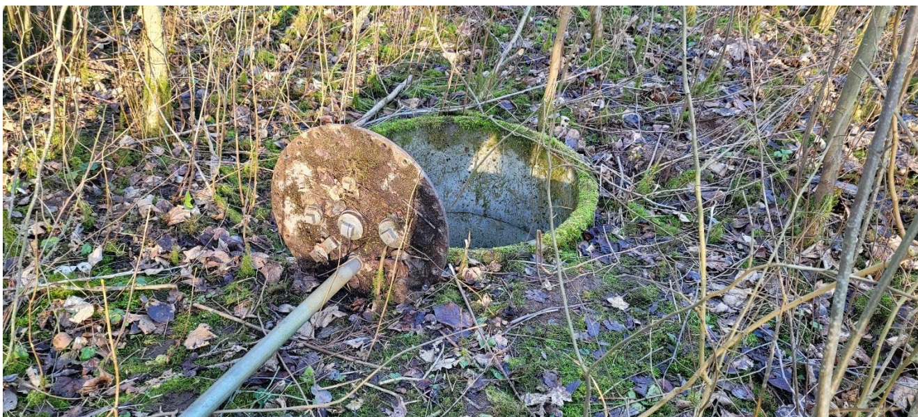
Åbning til nedgravet regnvands-/sikkerhedstank for afløb fra befæstet påfyldningsplads.
