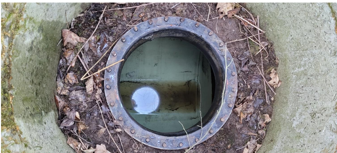
Regnvands-/sikkerhedstank er bundtømt ifm. tilsynet.
