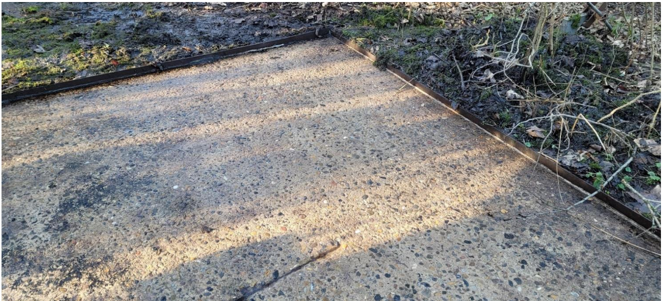
Befæstet påfyldningsplads med opkant.
