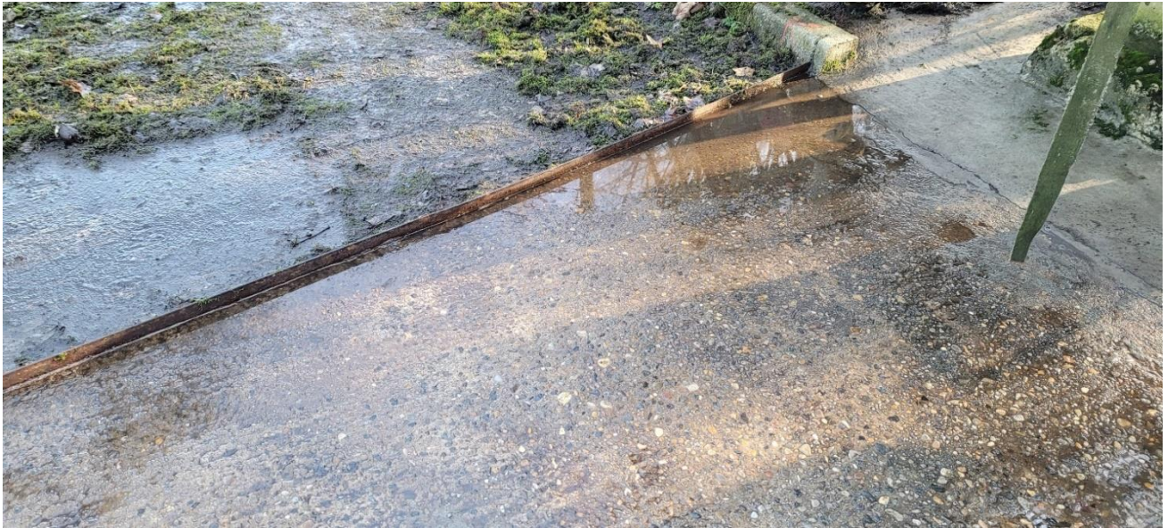
Befæstet påfyldningsplads med opkant.
