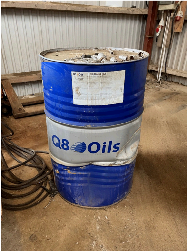
Figur 5. Olie-tønde direkte på gulv i maskinhus. Fjernes snarest.
