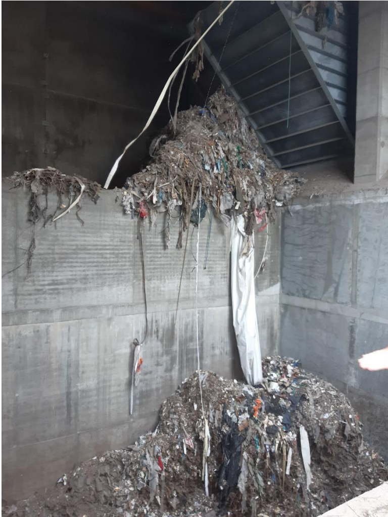
Silo til tørt erhvervsaffald
