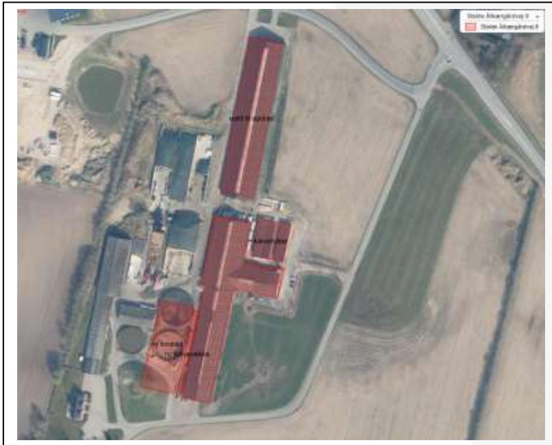
Figur 1. Ejendommen Ålkærgårdvej 9, med angivelse af stalde
