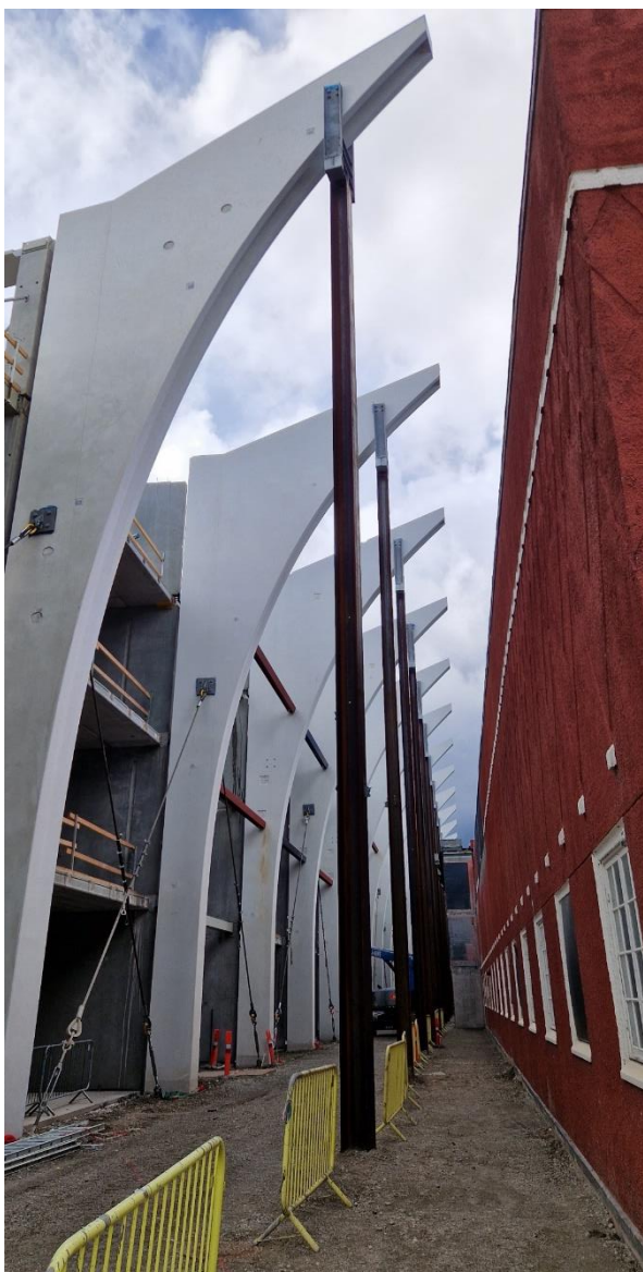
Det igangværende byggeri med det nye Aarhus Stadion. Her ses søjlerne til tribunen mod den gale eksisterende røde bygning.
