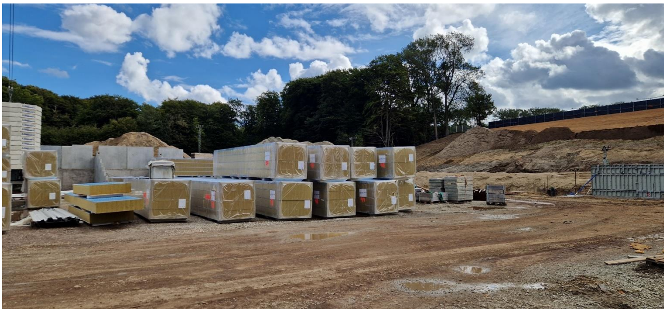
Det igangværende byggeri med det nye Aarhus Stadion. I baggrunden ses den spunsede terrænhældning over mod travbanen.
