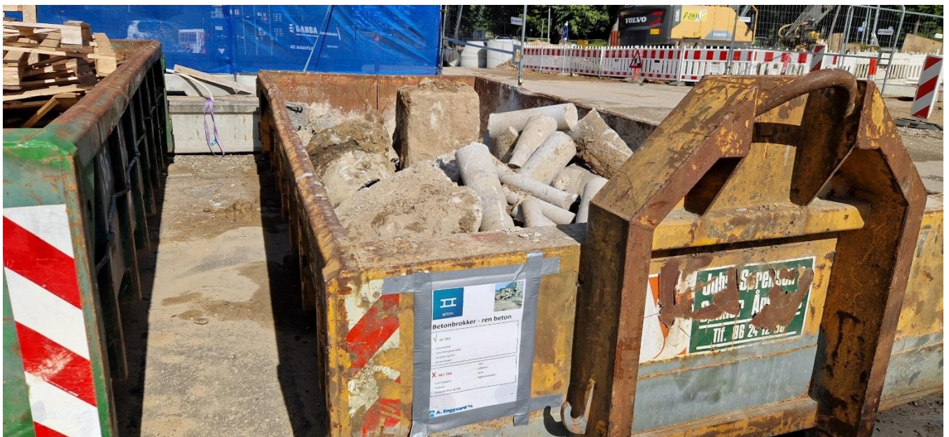
Container til betonbrokker.
