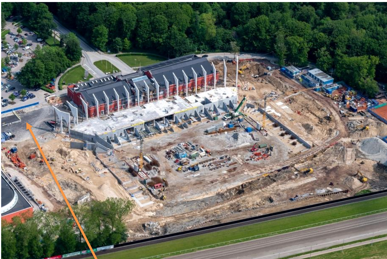
Luftfoto af det igangværende byggeri med det nye Aarhus Stadion.
