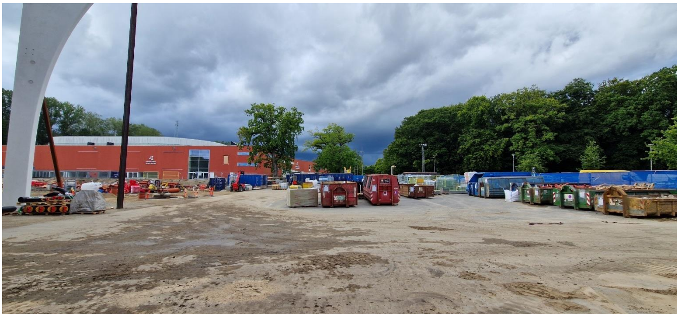
Det igangværende byggeri med det nye Aarhus Stadion. Her ses det asfalterede areal, hvorunder forurenet betonslagge er indbygget. Pladsen benyttes til affaldshåndtering ifm. byggeriet.
