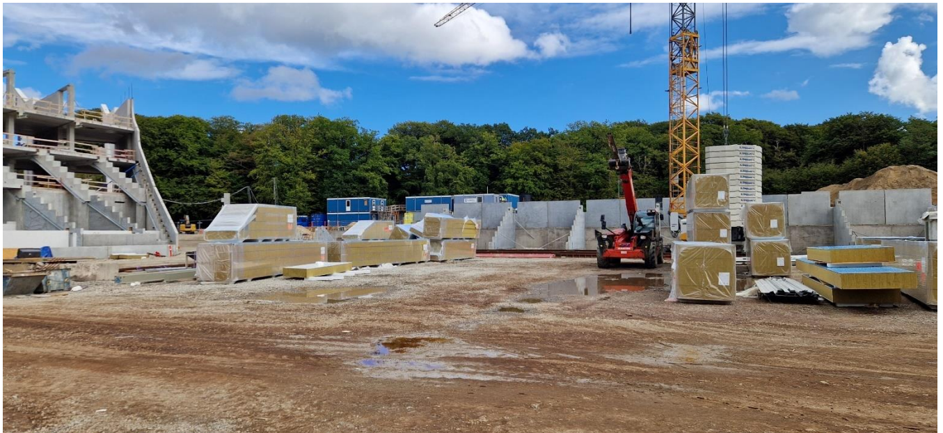
Det igangværende byggeri med det nye Aarhus Stadion. Her ses den kommende boldbane, hvor nedknust ren beton midlertidigt er indbygget under byggepladsen.
