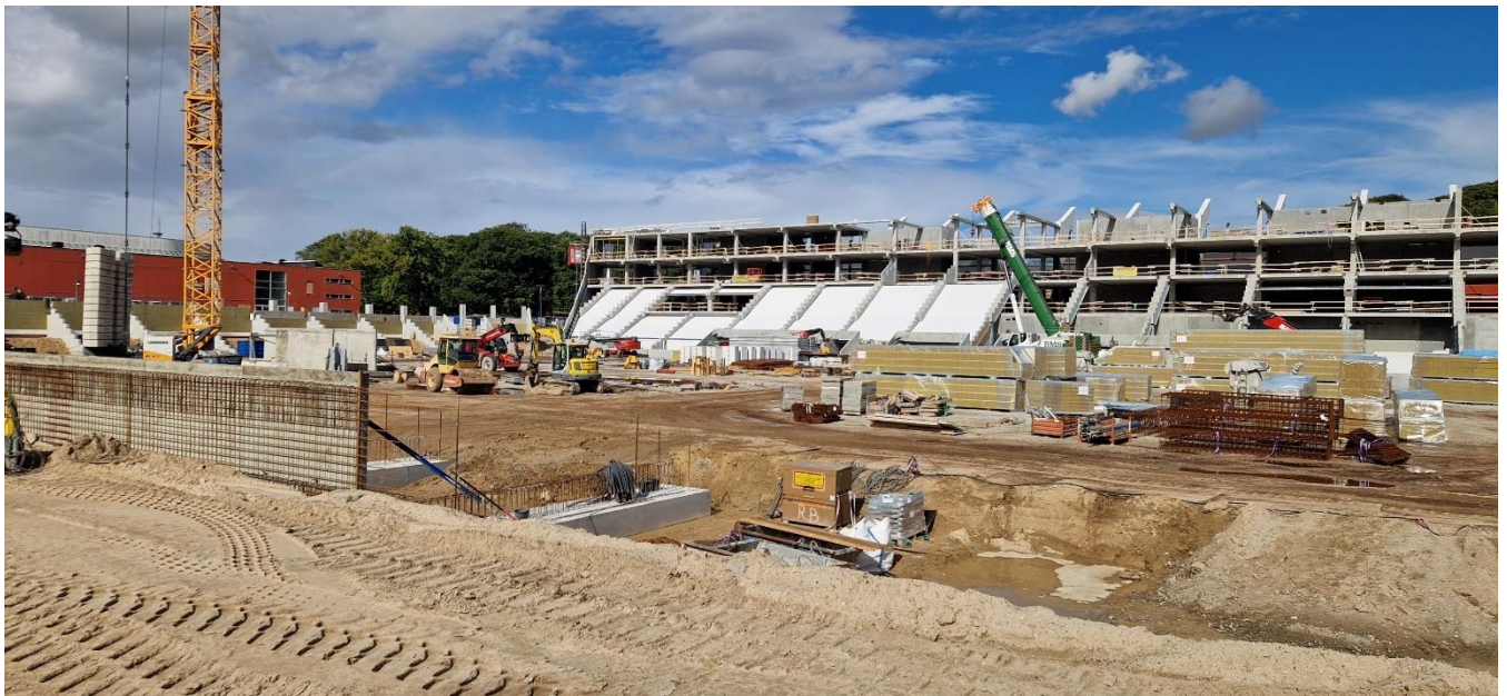
Det igangværende byggeri med det nye Aarhus Stadion.
