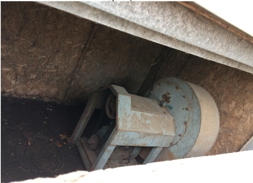
Billede 10 - Motorer udenfor var støjdæmpet med kasse.
