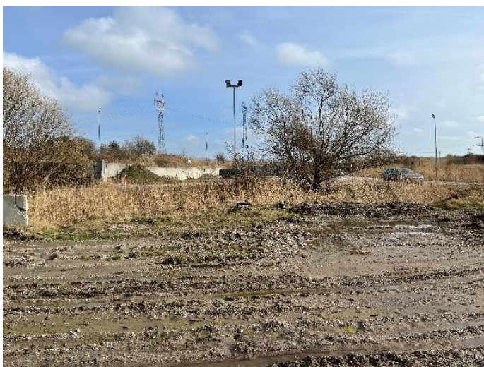
Figur 3 Asfaltplads med b se er intakt. Installationer med lys er intakte.
