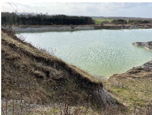
Figur 8 Skråningsanlæg mod Støvsøen er meget stejlt.
