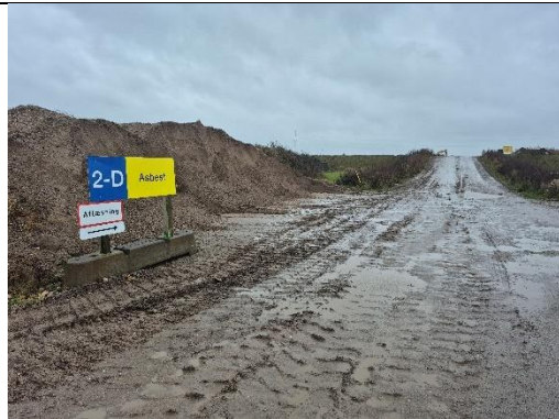
Opkørsel til etaper II enhed D
