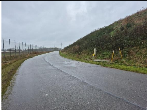
Østsiden af deponiet med etape I enhed B og C til højre
