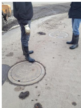
3 Brønddæksler: 1. Sandfang, 2. Olieudskiller, 3. Sam
