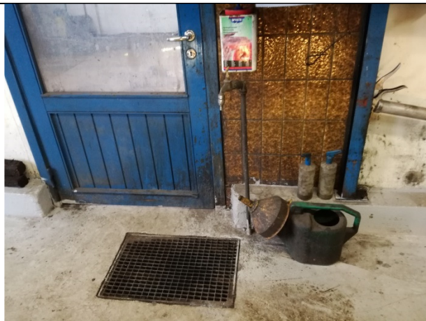
Billede 6: Afløb til olieudskiller
