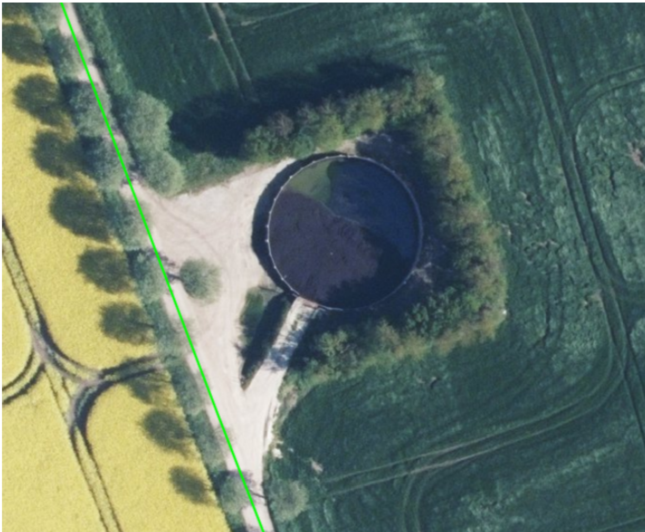
Slamlager, fritliggende gyllebeholder på Blegvadbrovej 3. Blegvadbrovej, markeret med grønt, er en kommunevej.
