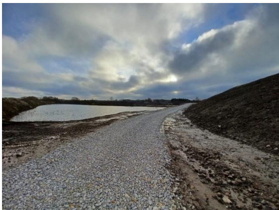
Foto 10: Deponeringsenhed 21 slået sammen med enhed 22, og udgravet. Set fra nordvestlige hjørne.
