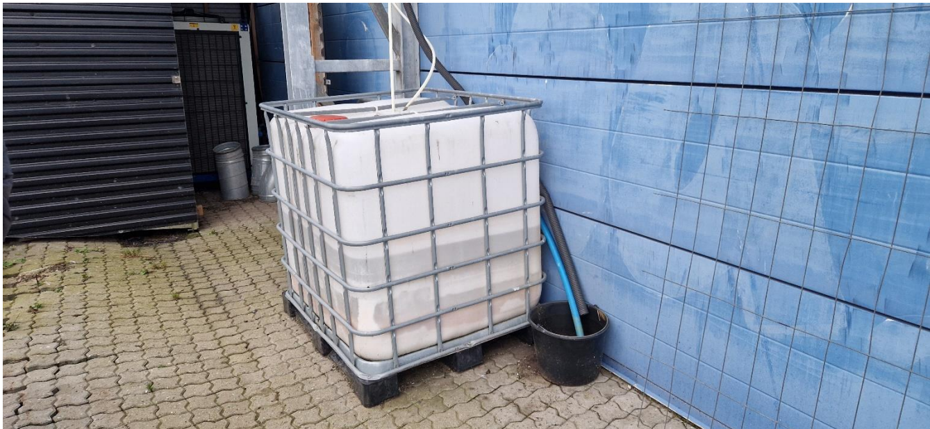
IBC til opbevaring af kondensat fra proces.
