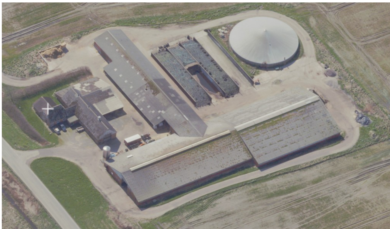
Figur. 5: Nuværende bygninger på Ved Gaden 4, set fra nord. Kilde: skraafoto.dataforsyningen.dk
