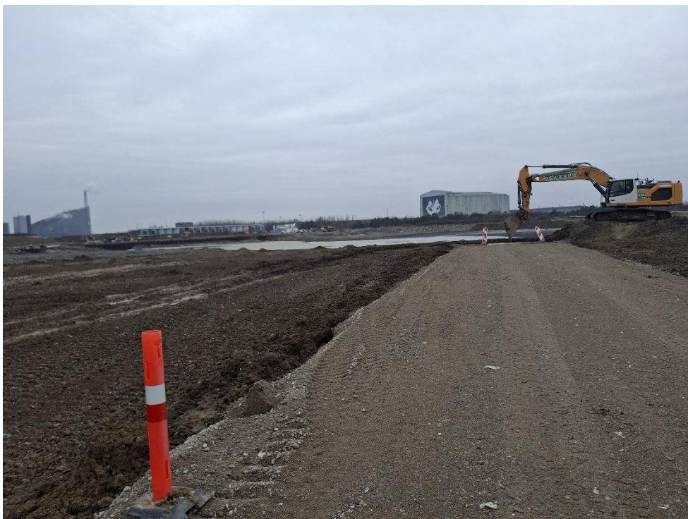
Figur 16. Kørevej til gravemaskinen der har slutfædækket på den østlige side af deponi.
