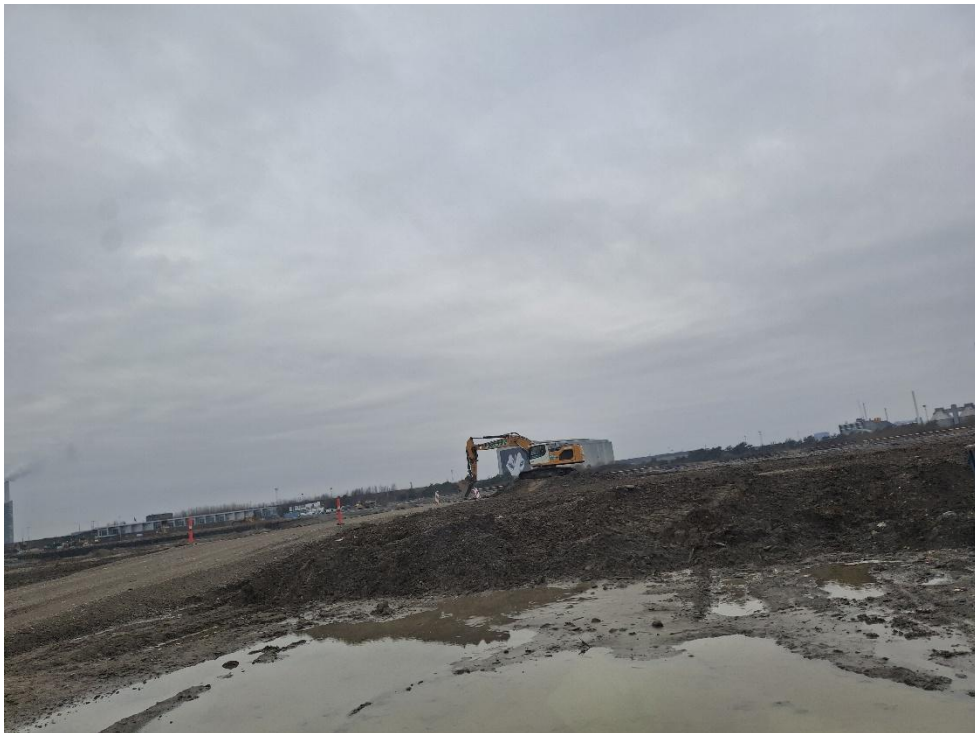
Figur 14. Udsigt til gravemaskine på det slutafdækkede område på østsiden- der ses tydelig adskillelse fra dæmningne til hvor deponiet står slutafdækket.
