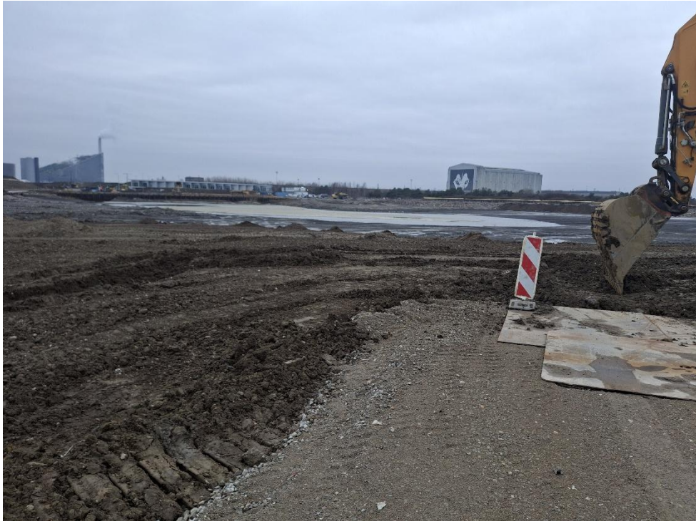
Figur 17. Gravemaskinen der har slutafdækket på den østlige side af deponi
