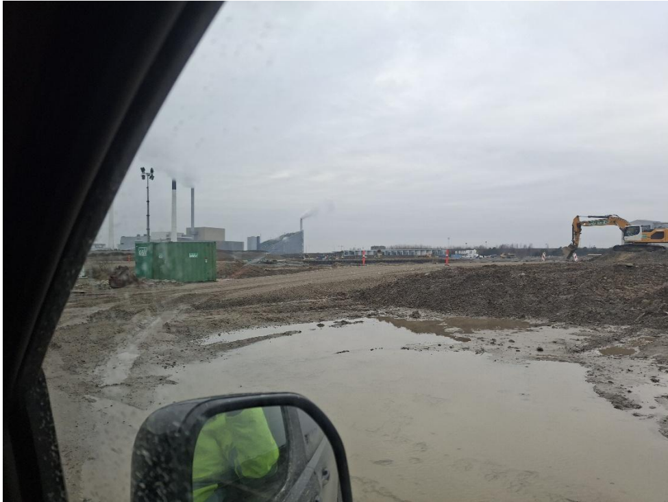
Figur 13. Udsigt ud over det slutafdækkede areal på østsiden hvor der holder gravemaskine. De to containere er på kanten af deponiet.
