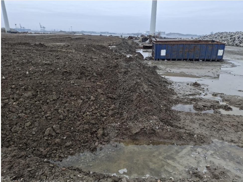
Figur 15. Tydelig adskillelse hvor der er slutfædækket til dæmning/dige/kørevej.
