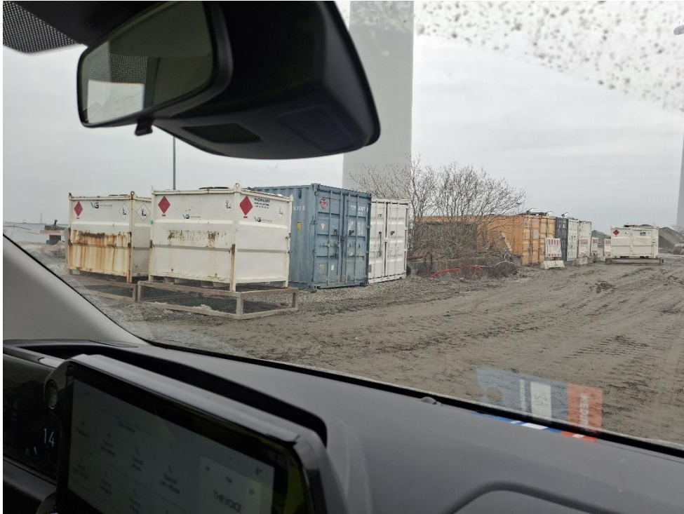
Figur 5. Flere forskellige containere under vindmøllerne på deponiets kajkant mod nord. Her var aktiviteter med jord håndtering i forb. med Lynetteholmen.
