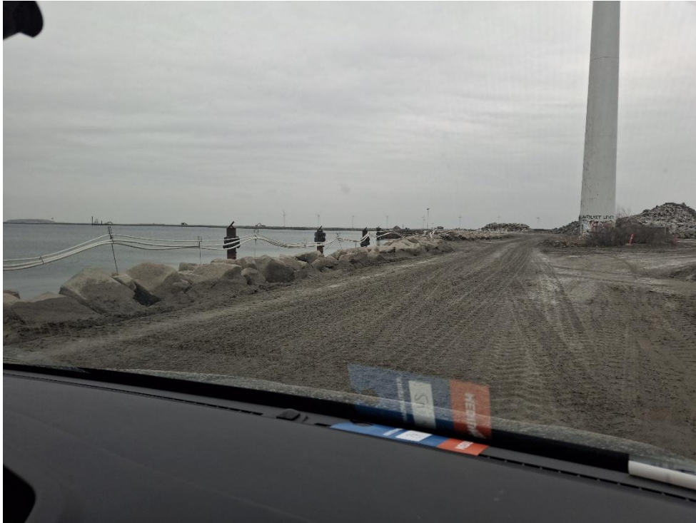
Figur 11. Efter kajajnten er der stadig kystsikring på deponiets norsside imod Lynetteholmen.
