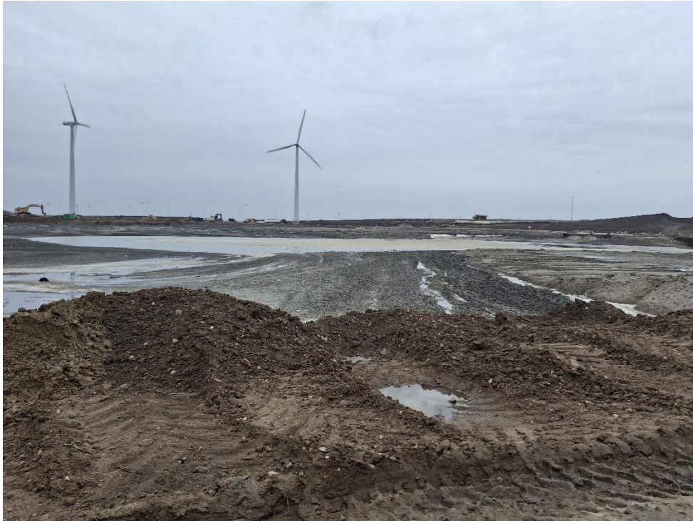
Figur 3. Der er lagt en enkelt læs ren jord til slutafdækning på deponiets vestlige side, dæk ude i det indspulede sediment ses til venstre.
