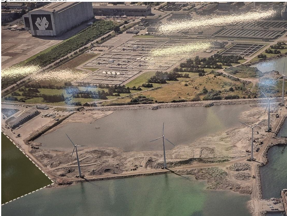
Figur 30 ældre luftfoto af deponiet af udstilling i formidlings container
