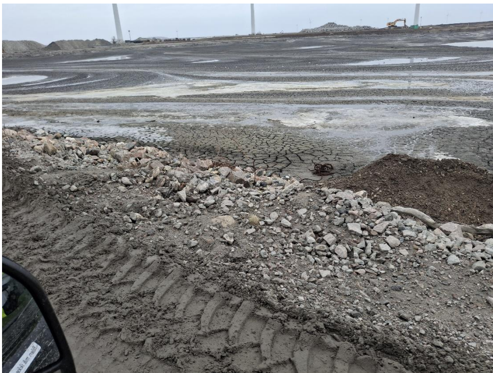
Figur 4. Udsigt mod øst fra deponiets vestlige dæmning/kørevej. Der er senest indspulet december 2025 og her ses stadig aflejringer på deponiet. Der ligger en metalwire og affald ude på deponiet som oplyses fjernes når der slutafdækkes.
