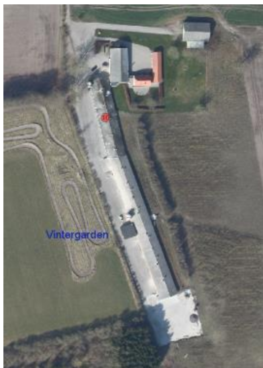
Figur 1. Oversigt over bygninger.
