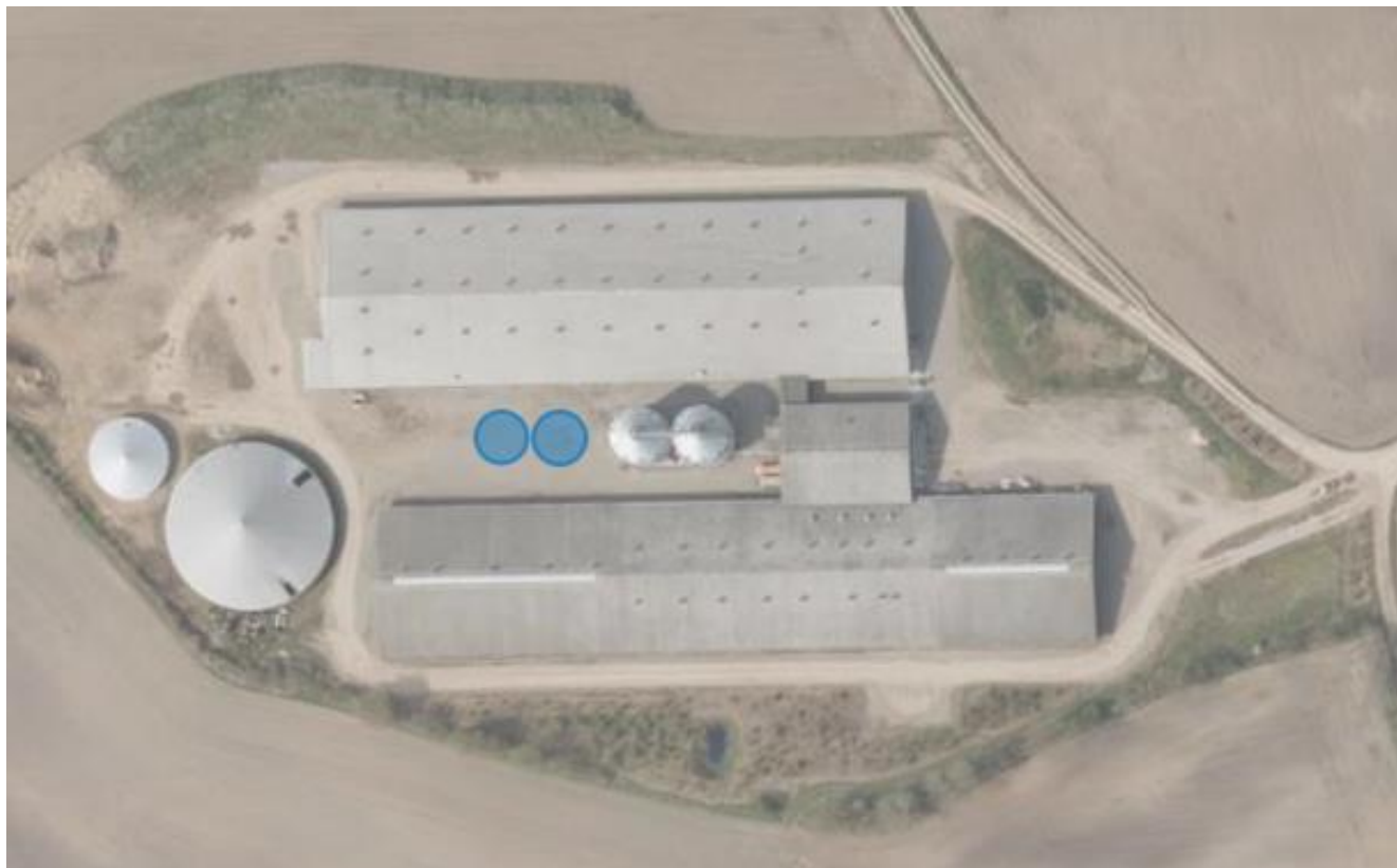
Figur 1. Oversigtskort over Kolstrup Bygade 11 med placering af de to nye kornsiloer.
