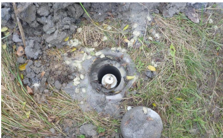
Billede af monitoringsboring.
