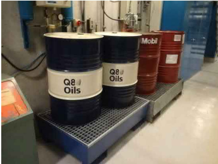
Figur 10: Tønder med olie til turbinens gaskompressorer.
