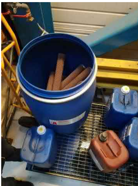
Figur 15: Farligt affald opbevares i lukkede beholdere (åbnet kun for foto) på et opsamlingskar.
