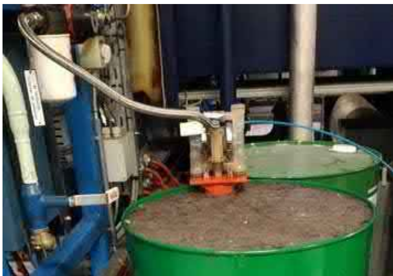
Figur 13: Oliepumpning fra tønder til tank.
