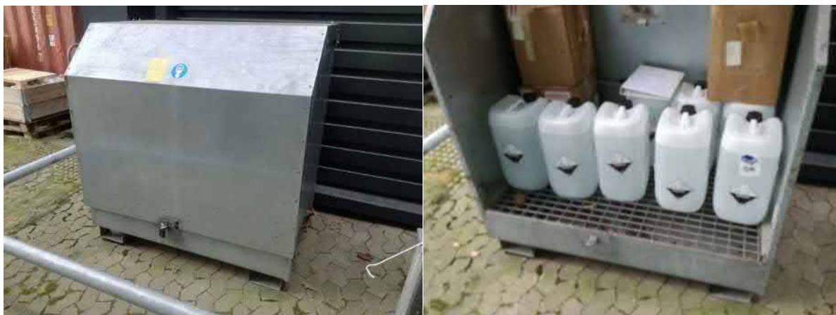
Figur 4: Udendørscontainer for ammoniak.
