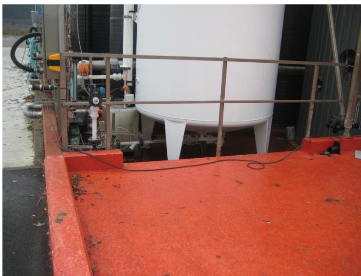
Billede 2. Afløb fra spildbakken til tankgraven.
