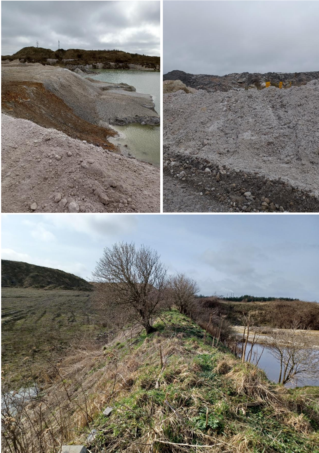
Figur 1. Øverst tv: Støvsøen med overfladevandssø. I baggrunden ses Aalborg Kommunes deponeringsanlæg. Øverst th: Skilte på anlægget var uhensigtsmæssigt placeret bag affald. Nederst: Vold mellem Støvsøen og Aalborg Kommunes deponi.
