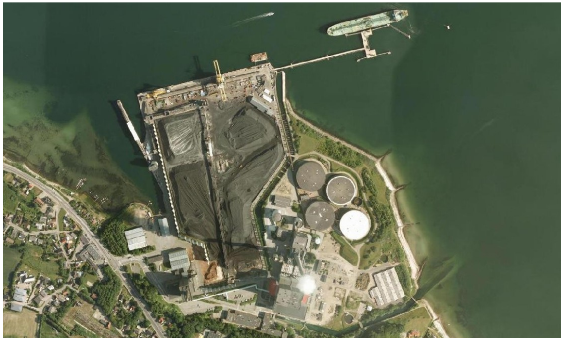
Figur 1 Luftfoto af EOT med de fire tanke og oliepier.
