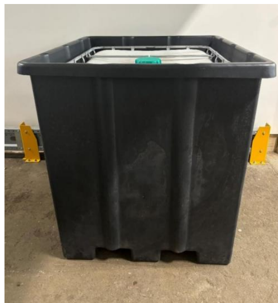
Avista Oil spildolietank med opsamlingskar
