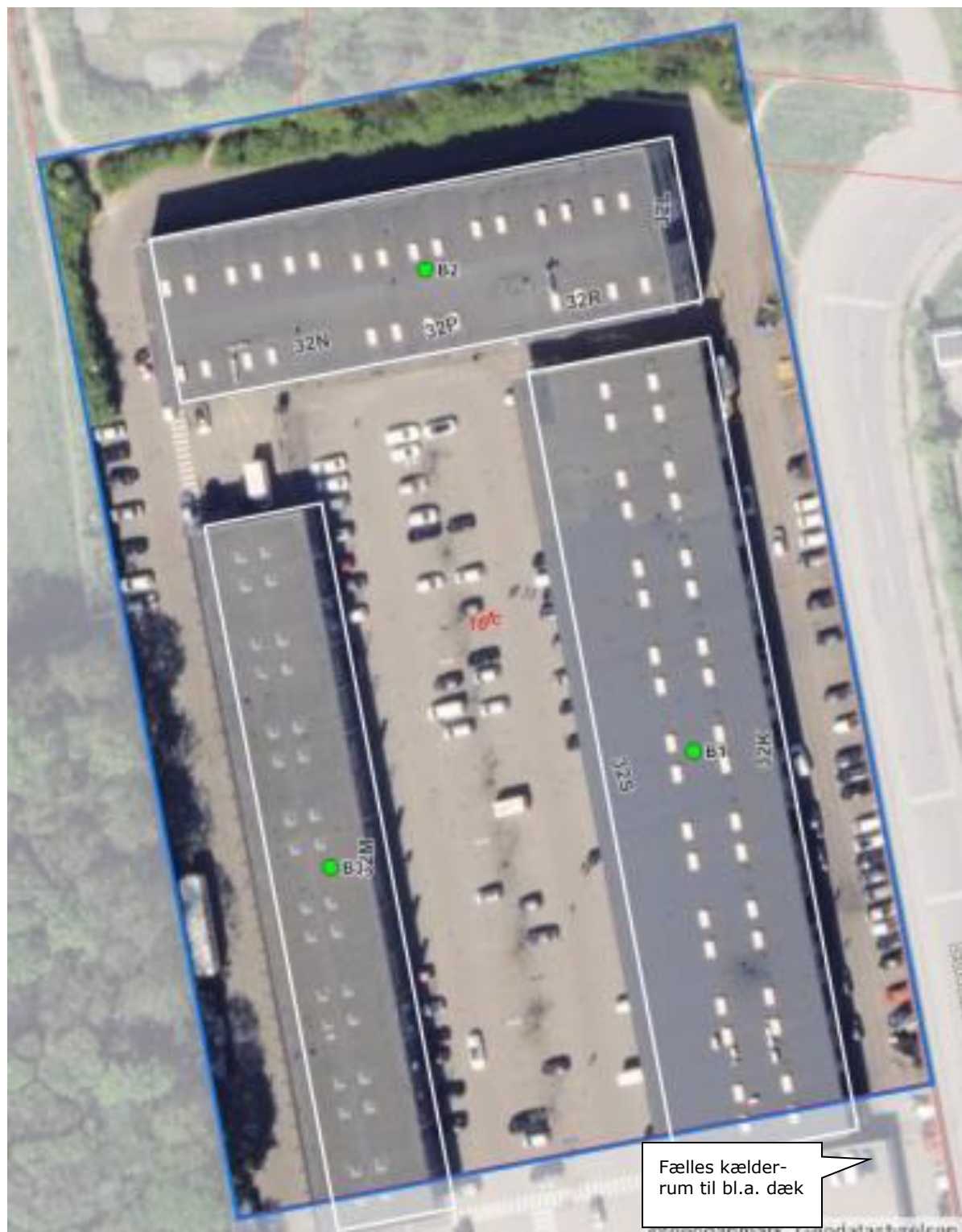
Luftfoto af ejendommen med matrikelskel fra BBR
