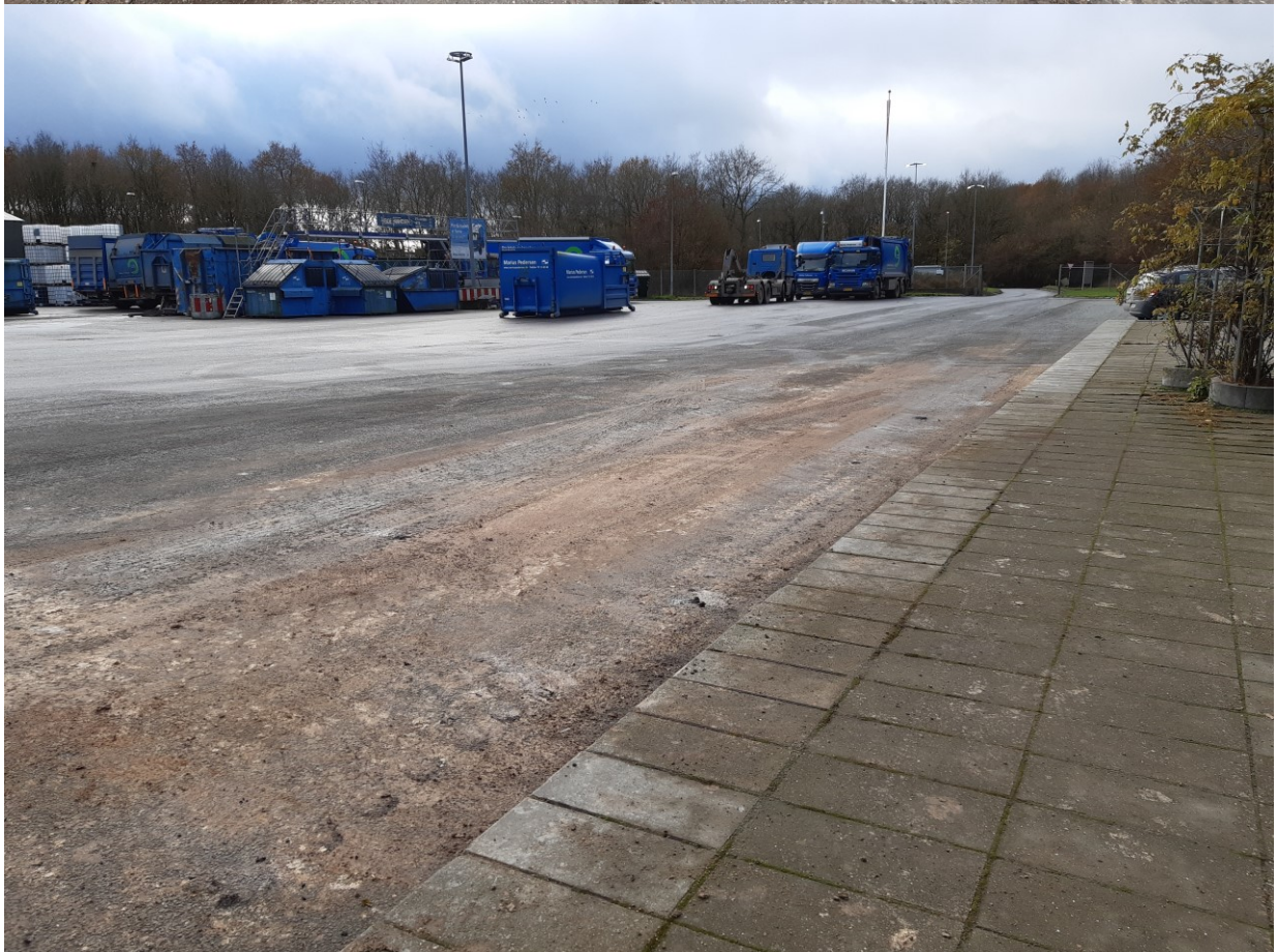
Skrottede rør fra overheder og tilsmudset forplads
