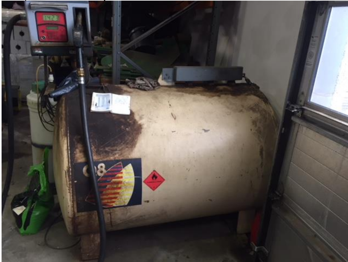
Tank på Hammelsevej 16
