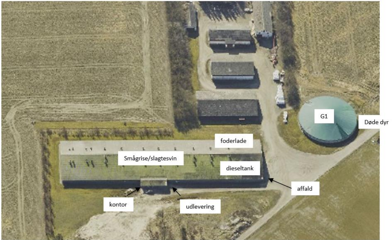
Staldanlægget set fra nord
