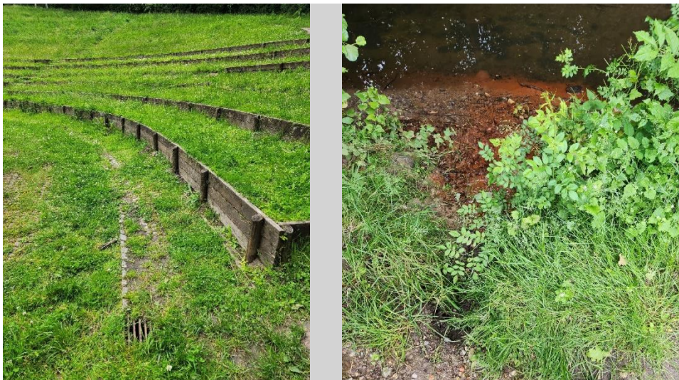
Foto 1 a og b. Rist i afvandingskanal for overfladevand samt udløb af overfladevand i Donse Å.
