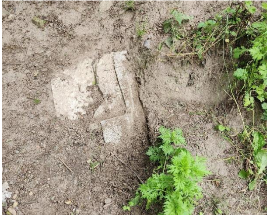
Foto 11: Et flisegulv stikker ud af deponiet.
