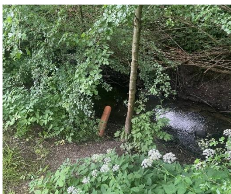
Foto 4: Perkolat fra Drænbrønd Øst ledes direkte ud i Donse Å tæt ved drænbrønden. Dette sker via det orange rør
