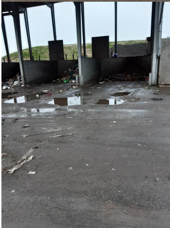
Figur 5: Båse hvorfra dagrenovation grabbes op i container.
