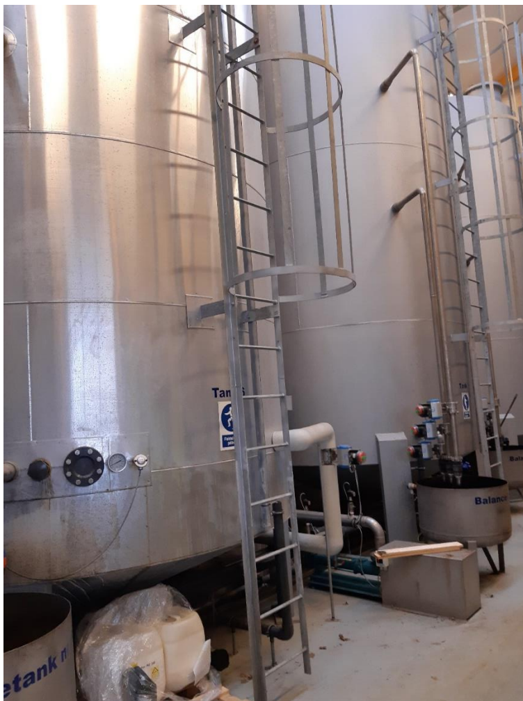
Figur 1: Olie separationsanlæg, 3 tanke på hver 40 m 3 .
