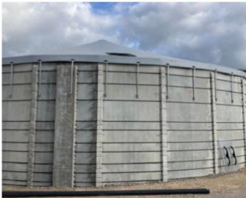
Figur 4-4: Muligt udseende af cirkulær buffertank med presenning.
