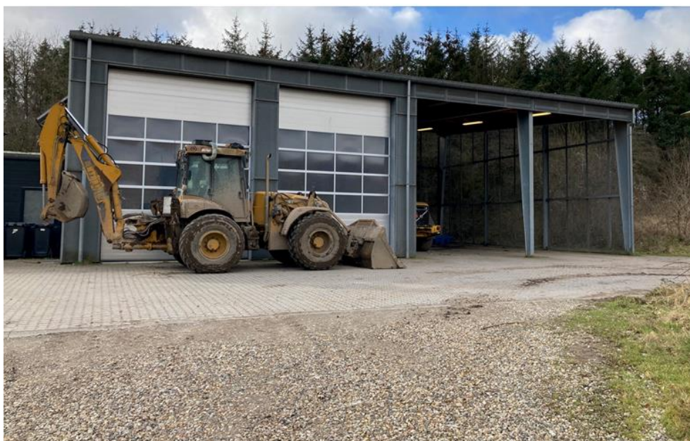
Figur 4-1: Eksisterende værksted, der skal bruges til etablering af renseanlæg for PFAS.
