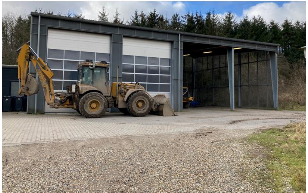
Figur 2-3: Eksisterende værksted/vognly, som man påtænker at renseanlægget for PFAS kunne blive etableret i.
